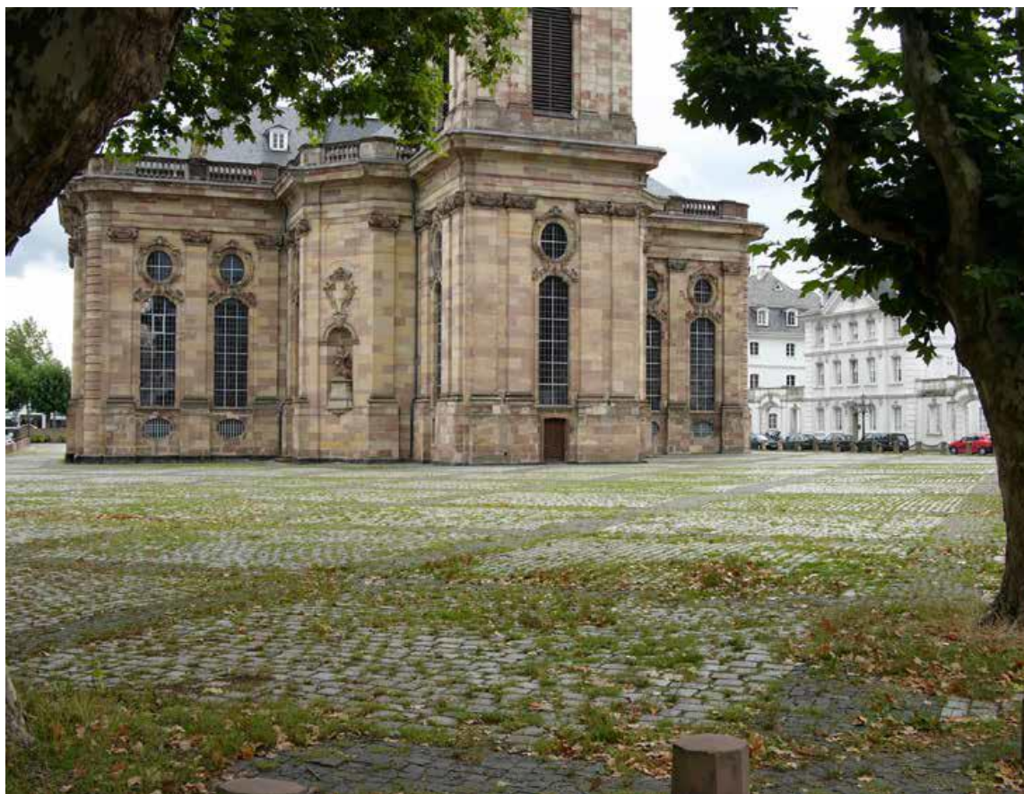
Foto 23: A vegetação nas juntas dos paralelepípedos de cobertura de solo pode ser cortada uma vez no verão se necessário.
