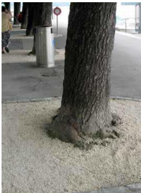
Foto 7: Canteiro para árvore com substrato de brita. Aspecto novo após intervenção.
