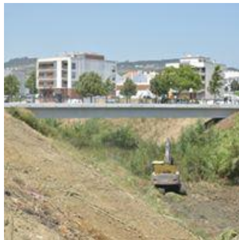
Foto 2 - Intervenção de remoção da vegetação com presença de maquinaria pesada no leito do rio
