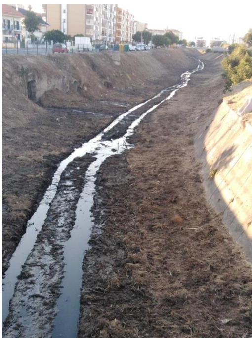
Foto 3 – Diversas condutas de descarga para o rio
