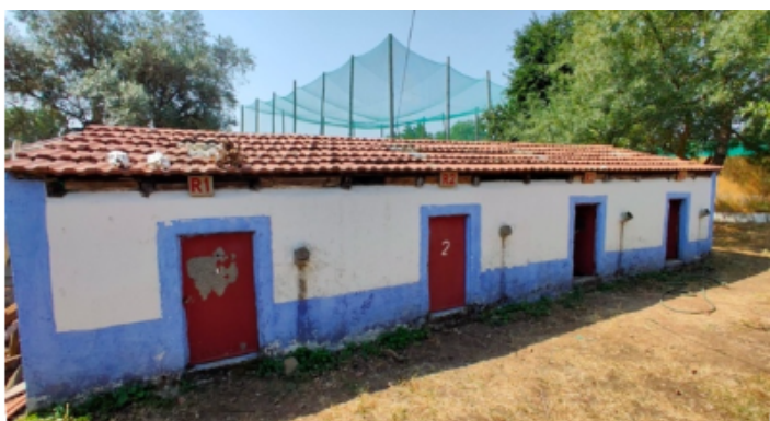
Figura 11: Exterior das câmaras de recuperação.
