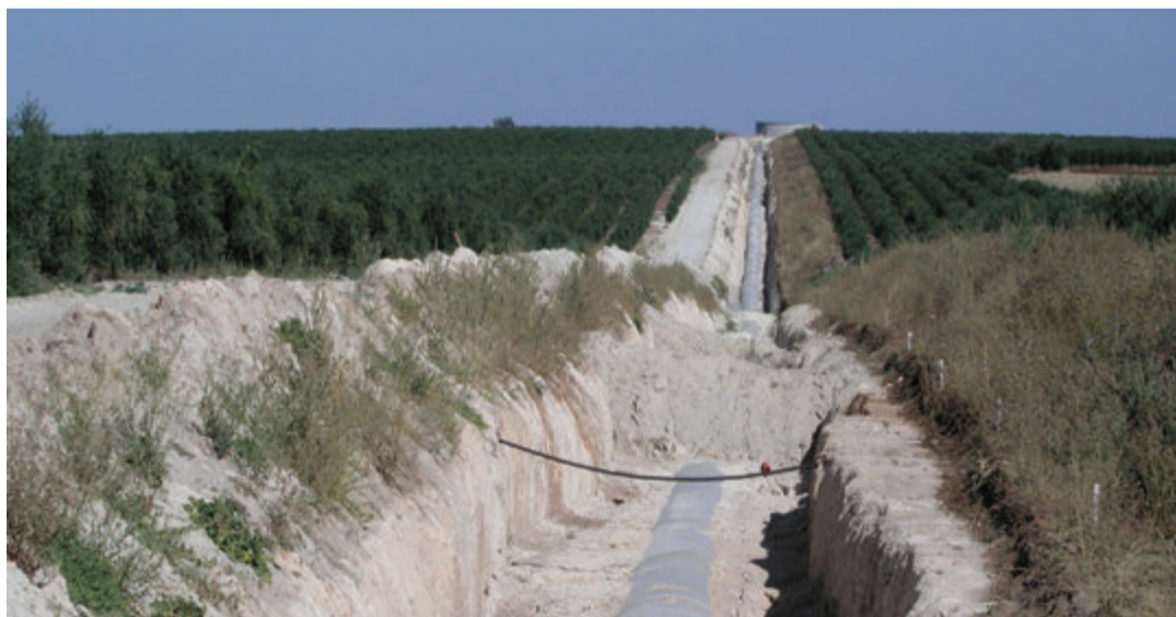
Regadio do Alqueva - condutas
