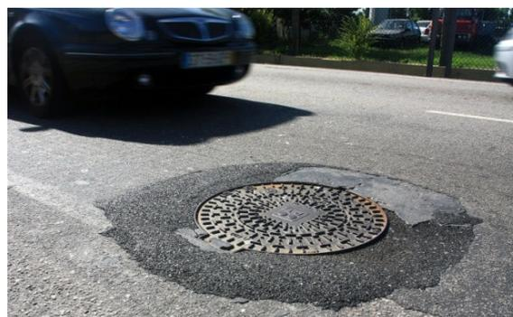
Fig. D2 – Caixas de visitas com juntas desniveladas em relação à superfície envolvente.
