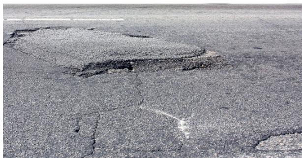
Fig. D3 – Irregularidades devido a emendas mal efectuadas (depressões e lombas)
